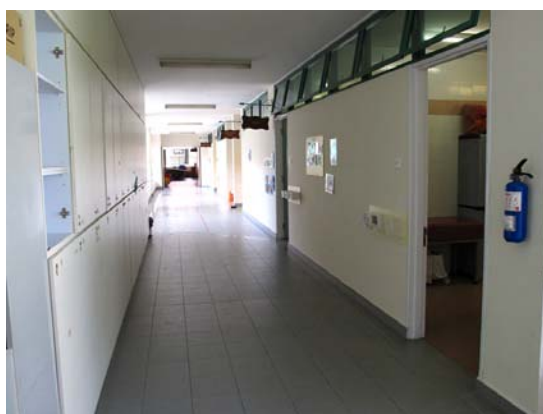
ทางเดินของอาคาร
